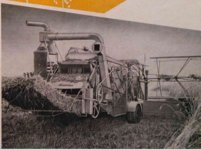
Abb. 142: Der Kombinus E162 war der erste Mähdrescher von Fortschritt. Dieser gezogene Mähdrescher war wie der Super von Claas nach dem Quer-Längs-Fluß-Prinzip aufgebaut und hatte eine Schnittbreite von 2,1 Meter. (Fortschritt 1956/Archiv Kühnstetter)
